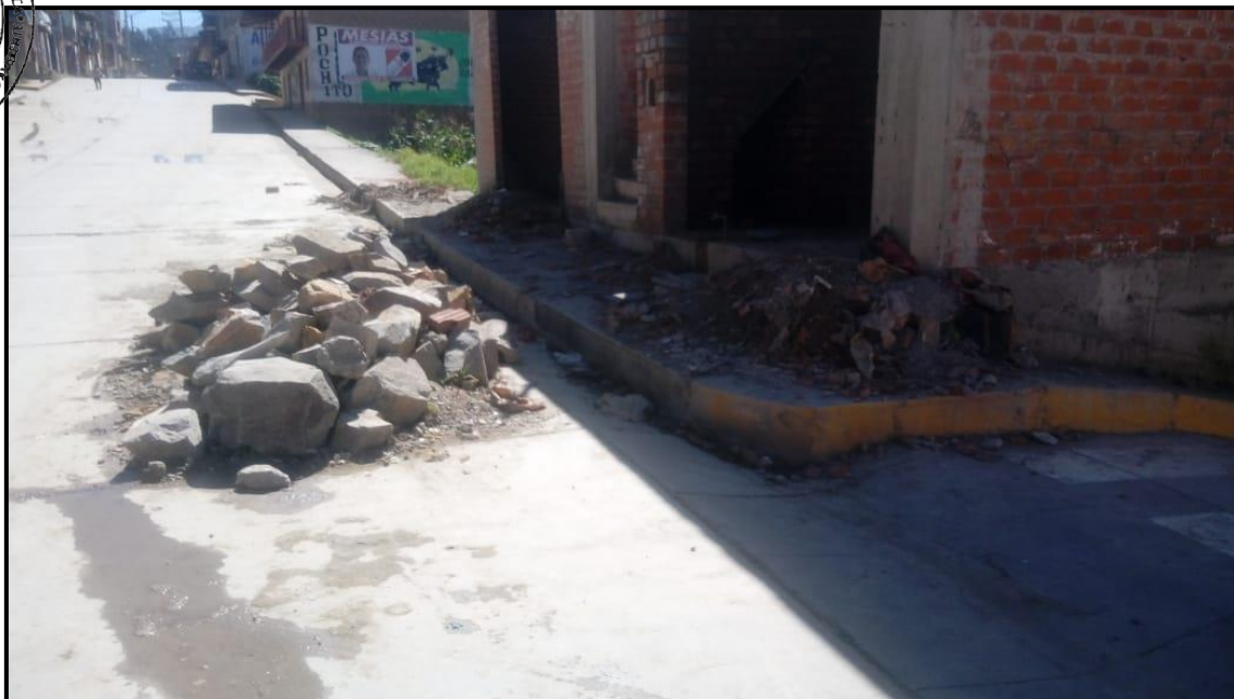
Fotografía N° 16: Ubicación entre Jr. Los Andes y el barrio “la quinta”
