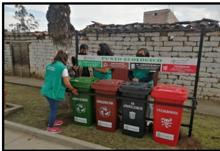
Figura N°3 Instalación del punto ecológico en el parque San Juan
